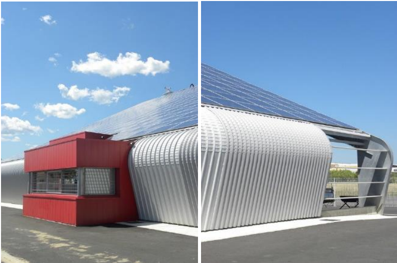
Installation PV sur la caserne de pompiers à Magalas
