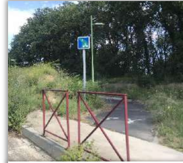
Voie verte correctement dimensionnée assurant pour partie la liaison Magalas <-> ZA
