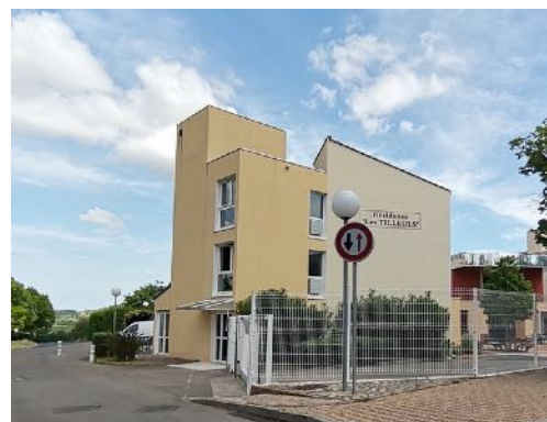
Ehpad Foyer Résidence Les Tilleuls Source : Urban Projects
