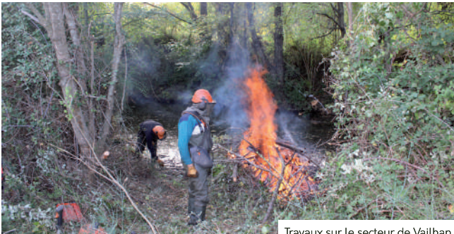
Travaux sur le secteur de Vailhan
