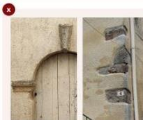
L'épaisseur de l'enduit est homogène et recouvre ou crée une sur-épaisseur au niveau des encadrements
