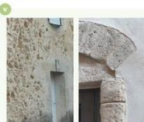
Le mortier vient affaisser et mourir sur les pierres d'encadrements
