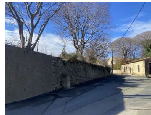
Photo n°1 : Mur donnant sur le Cami de Pézenas
