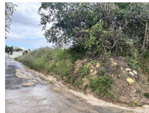
Photo n°2 : Entrée Chemin de l'Aramon
