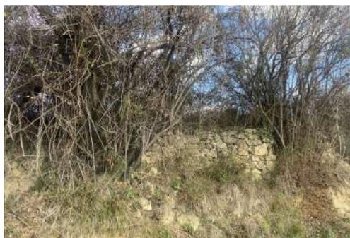
Photo n°4 : Muret de soutènement
