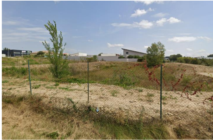
Figure 5 : bassin de rétention de la ZAE l'Audacieuse
