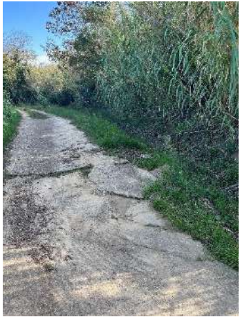
(2) Ecoulement préférentiel et expansion des eaux pluviales sur chemin de service
