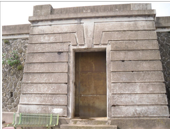
Accès à la chambre de vanne et réservoir
