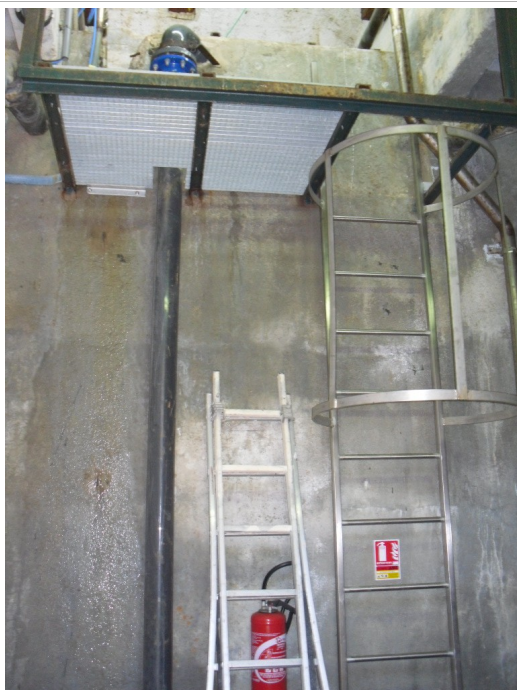
Accès à la cuve de stockage
