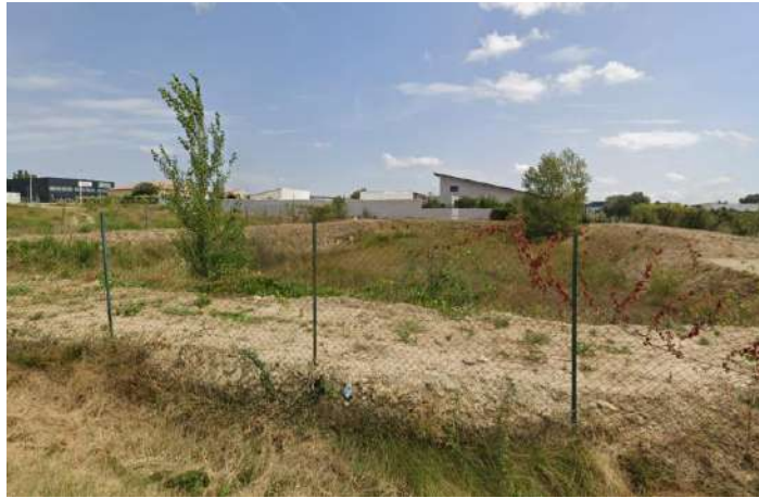
Figure 5 : bassin de rétention de la ZAE l'Audacieuse
