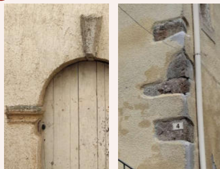
L'épaisseur de l'enduit est homogène et recouvre ou crée une surépaisseur au niveau des encadrements
