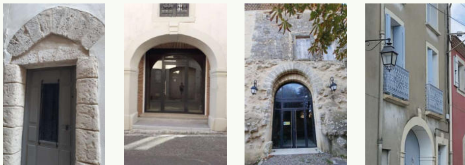
Exemple de menuiseries contemporaines s'intégrant et s'adaptant à l'ouverture existante
