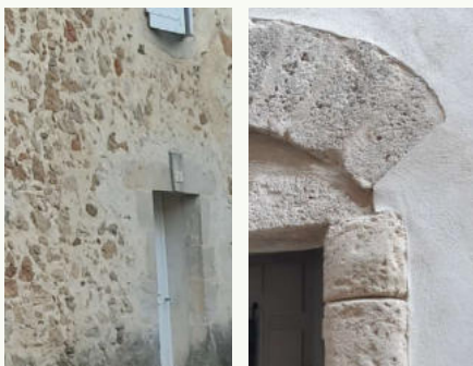
Le mortier vient affleurer et mourir sur les pierres d'encadrements
