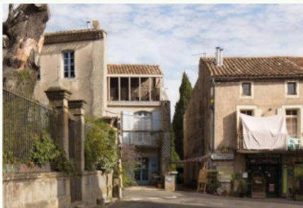
Surélévation d'un bâtiment en entrée de village- Sapiens- Montolieu (11)
