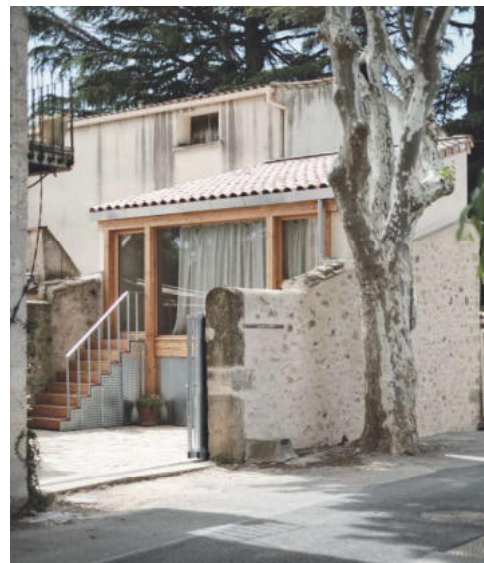
Construction d'une annexe en centre villageois - Le bâti en ossature bois vient s'appuyer sur l'existant formé de murs en pierre; L'utilisation de matériaux tels que la tuile canal et les enduit chaux intègre le projet dans le tissu ancien à l'instar de la volumétrie du bâti- Bako Studio - Dimitri Felouzis - Usclas d'Hérault (34)
