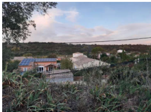
Contre-exemple d'une installation ne tenant pas compte de la façade
