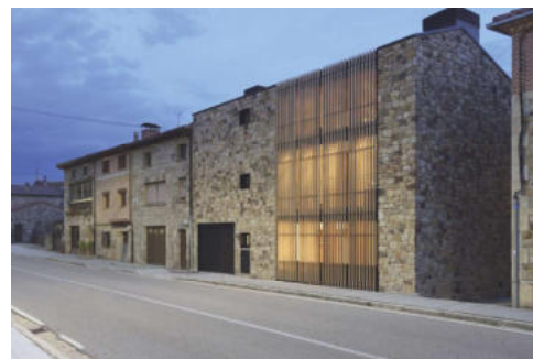
Maison de village respectant l'alignement avec le front bâti existant tout en proposant une façade à l'écriture contemporaine. Le bardage bois à claire-voie amène contraste avec les pierres tout en amenant un rythme à la façade - La Reina Obrera - Bam - Salduero (Espagne)
