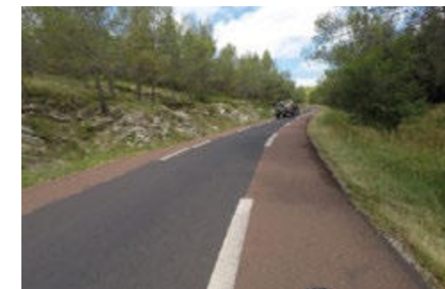
Chaussée à voie centrale banalisée aux Matelles (34)
