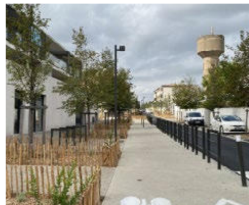
Traversée du centre de Colombiers - Torrès Borredon - Colombiers (34)
