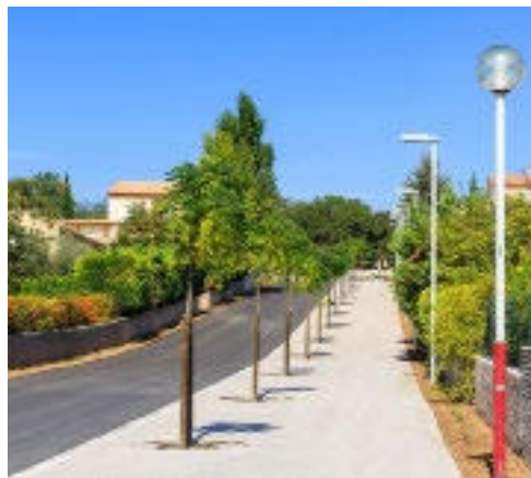
Plantation d'arbres et réhabilitation de trottoirs - INMS - Saint-Jean-de-Védas (34)
