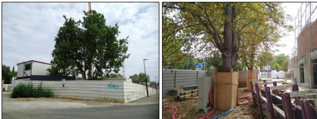
Figure 31. Chantier délimité par une barrière fixe (à gauche) ; Arbres protégés pendant un chantier (à droite).
