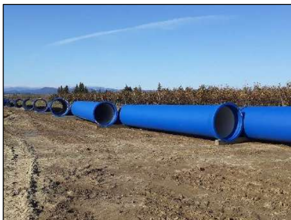
Travaux d'extension du réseau BRL sur la commune de Thézan-lès-Béziers
