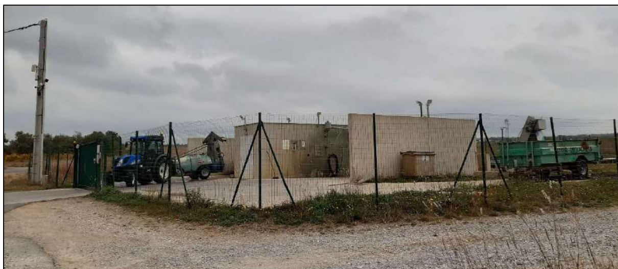
Aire de lavage/remplissage de Laurens
