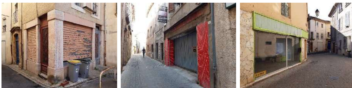
Commerces vacants au cœur du centre ancien de Murviel-lès-Béziers
