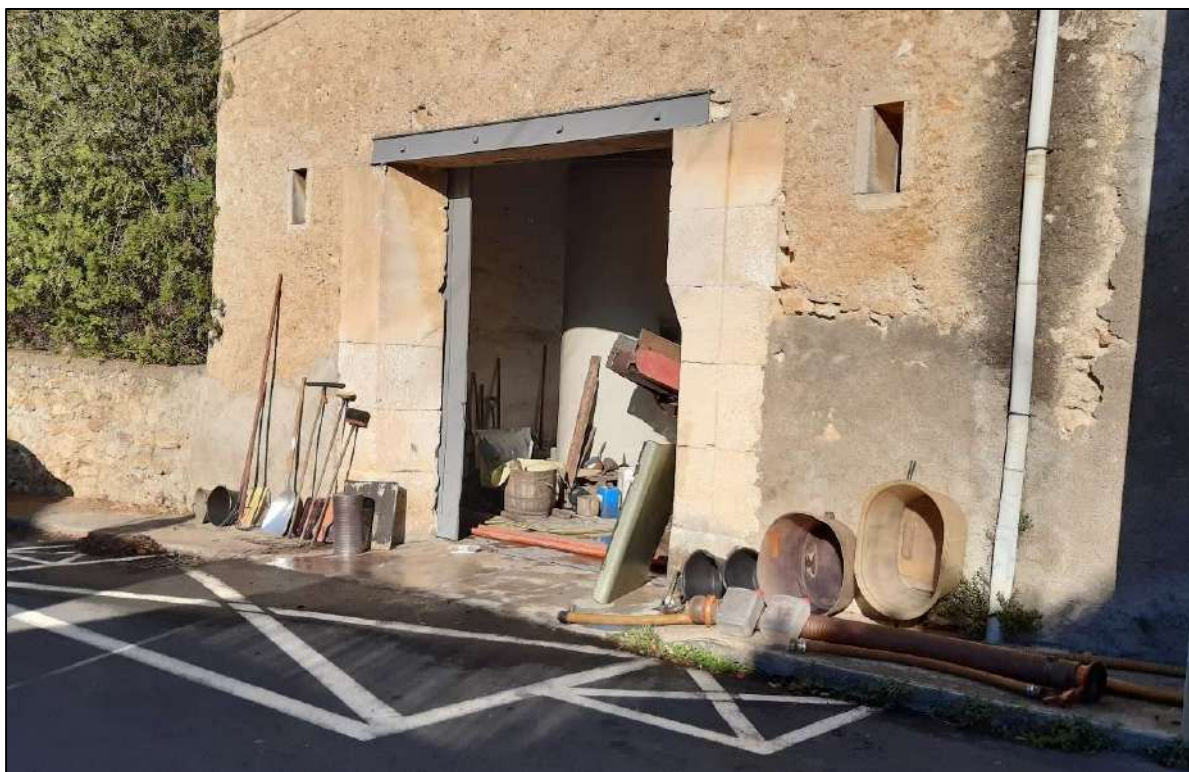
Exemple de cave particulière historique située à l'intérieur du tissu villageois à Murviel-lès-Béziers
