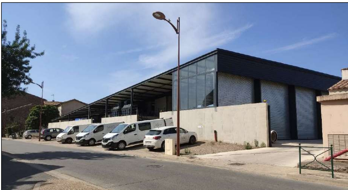
Exemple de cave particulière récente située à l'intérieur du tissu villageois de Pouzolles
