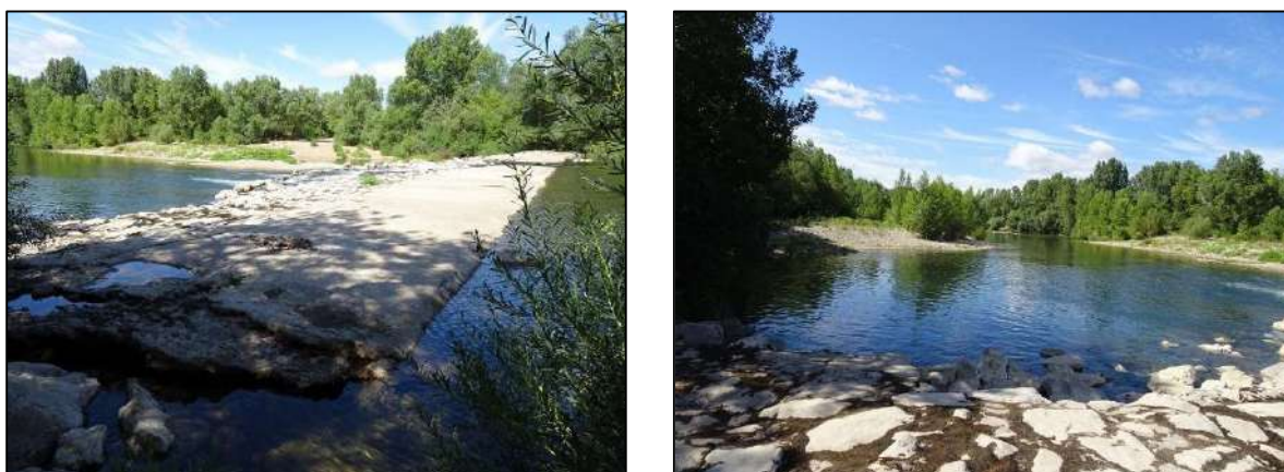
Figure 2. Le seuil Gaston Doumergue (à gauche) ; vue sur l'Orb depuis le seuil (à droite). Photos : MREnvironnement, 2021.
