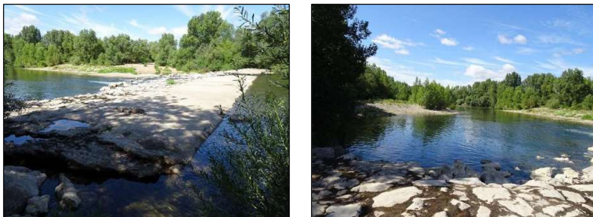
Figure 23. Le seuil Gaston Doumergue (à gauche) ; vue sur l'Orbière depuis le seuil (à droite). Photos : MREnvironnement, 2021.
