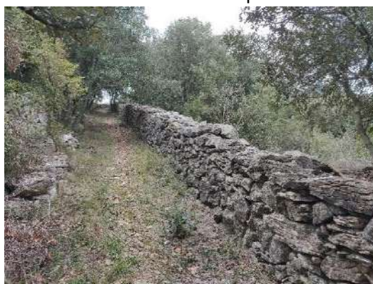
Figure 77. Exemple de mur de soutènement sauvegarder à Fauères.
