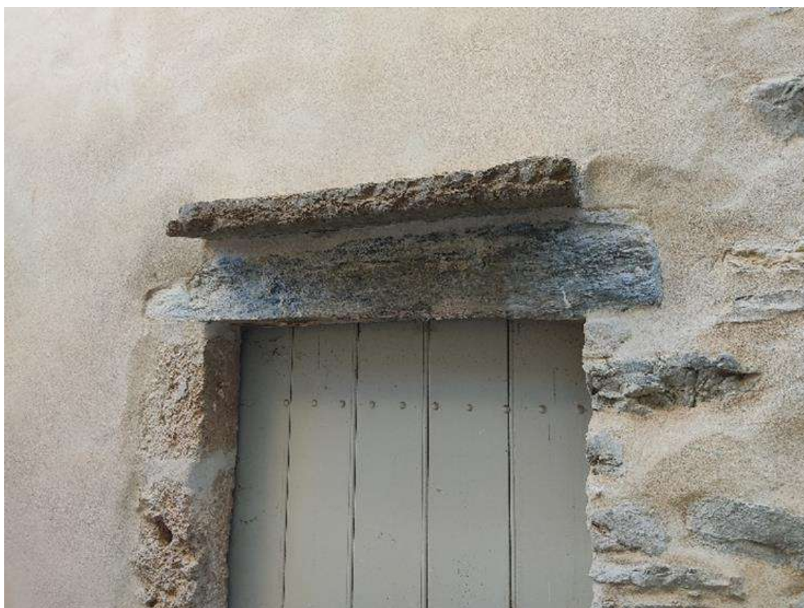
Exemple de lindeau droit (plate bande) en pierre à Roquessels
