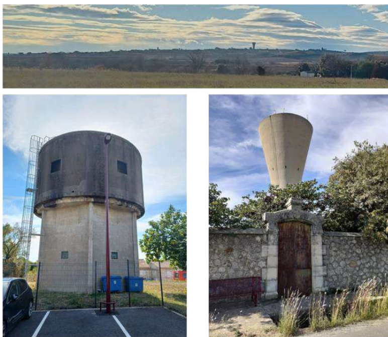
Figure 61. Châteaux d'eau de Pailhès et Autignac
