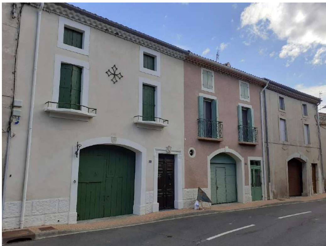
Figure 97. Tissu bâti éclectique au sein des faubourgs de Causses-et-Veyran
