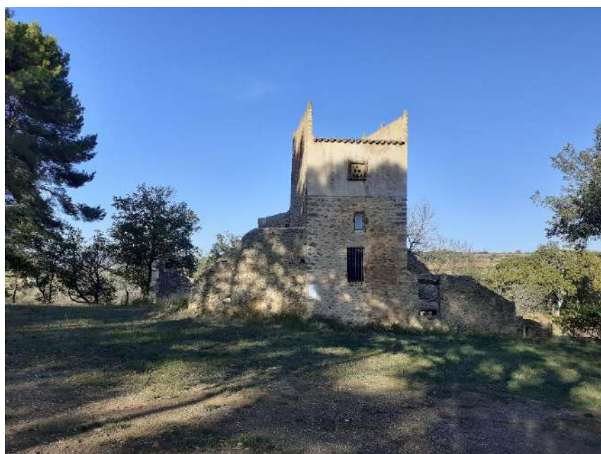
Figure 120. Pigeonnier d'Yvernès à Murviel-lès-Béziers
