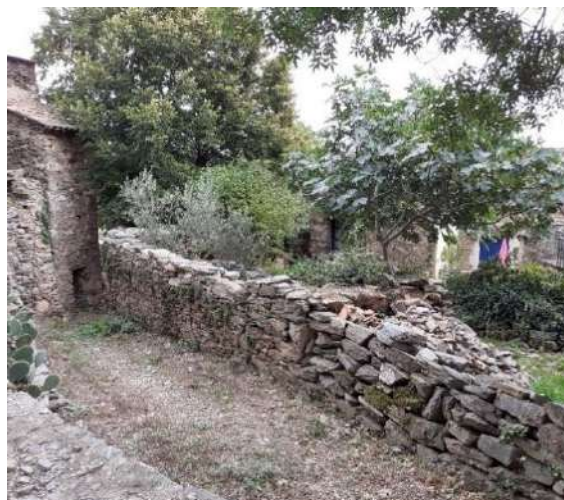
Figure 79. Mur de soutènement en pierre sèche à Cabrerolles.
