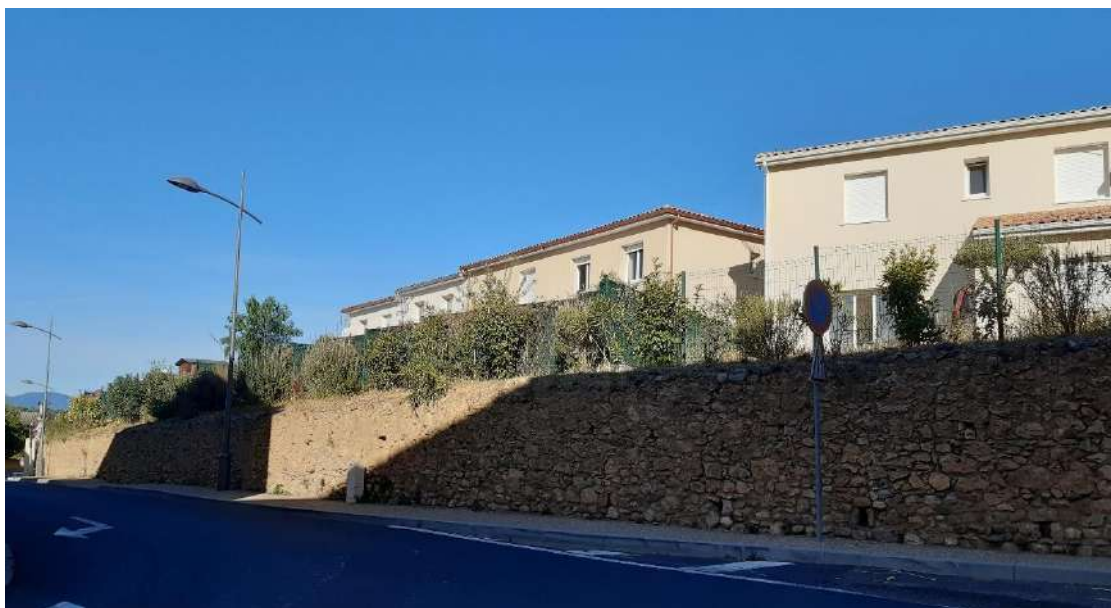
Figure 113. Habitat individuel groupé à Murviel-Lès-Béziers
