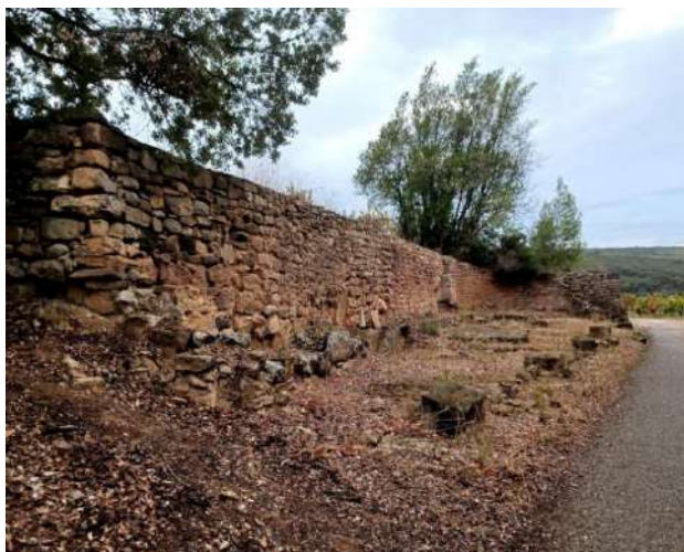
Figure 78. Mur de soutènement en pierre sèche à Neffiès.
