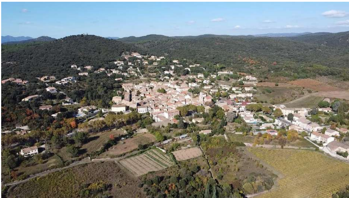
6. Vue par drone de la commune de Faugères au sein de l'unité paysagère des Avant-Monts.
