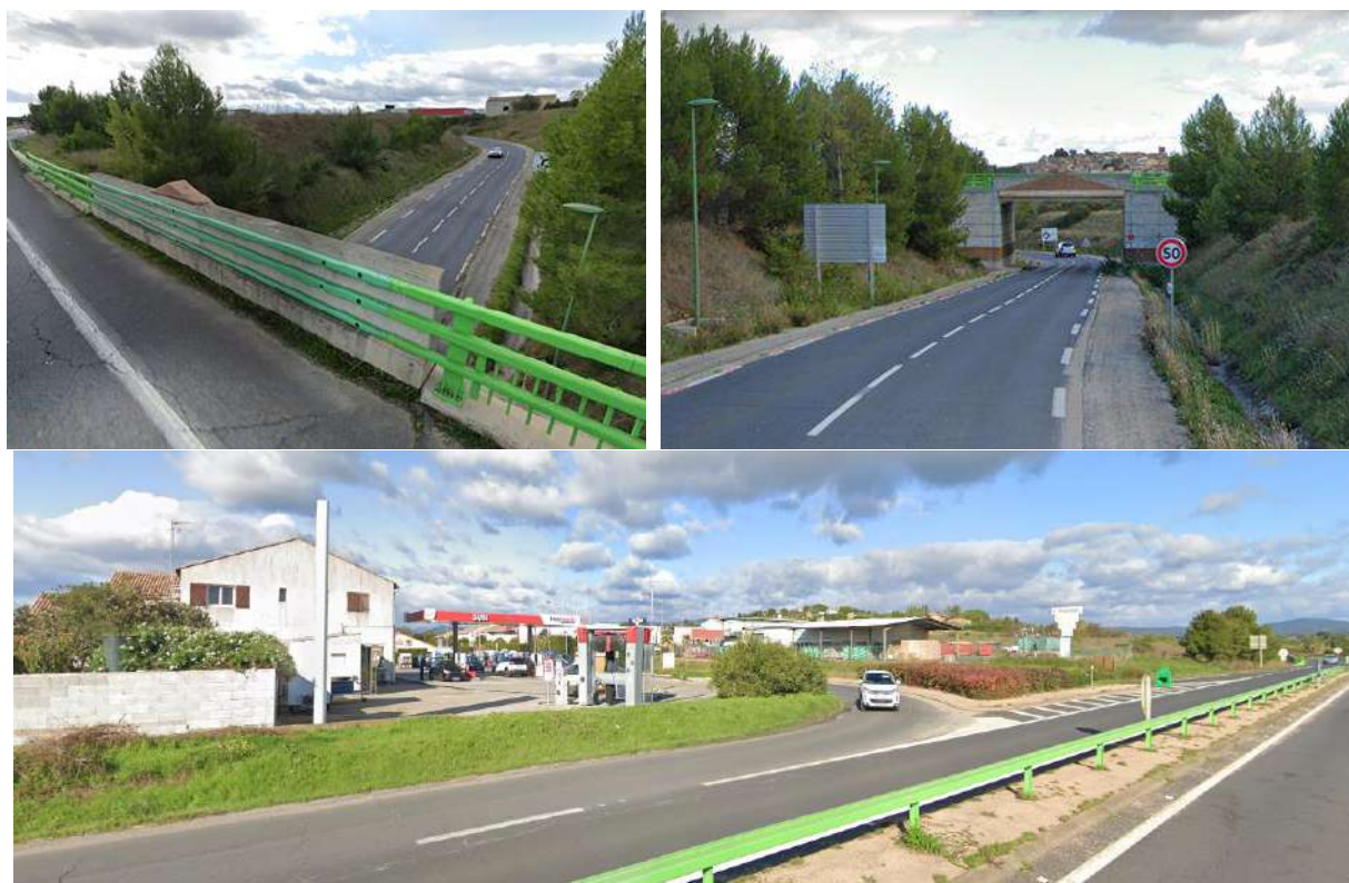
Figure 34. Echangeur à Magalas et routes départementale 909 et 108.
