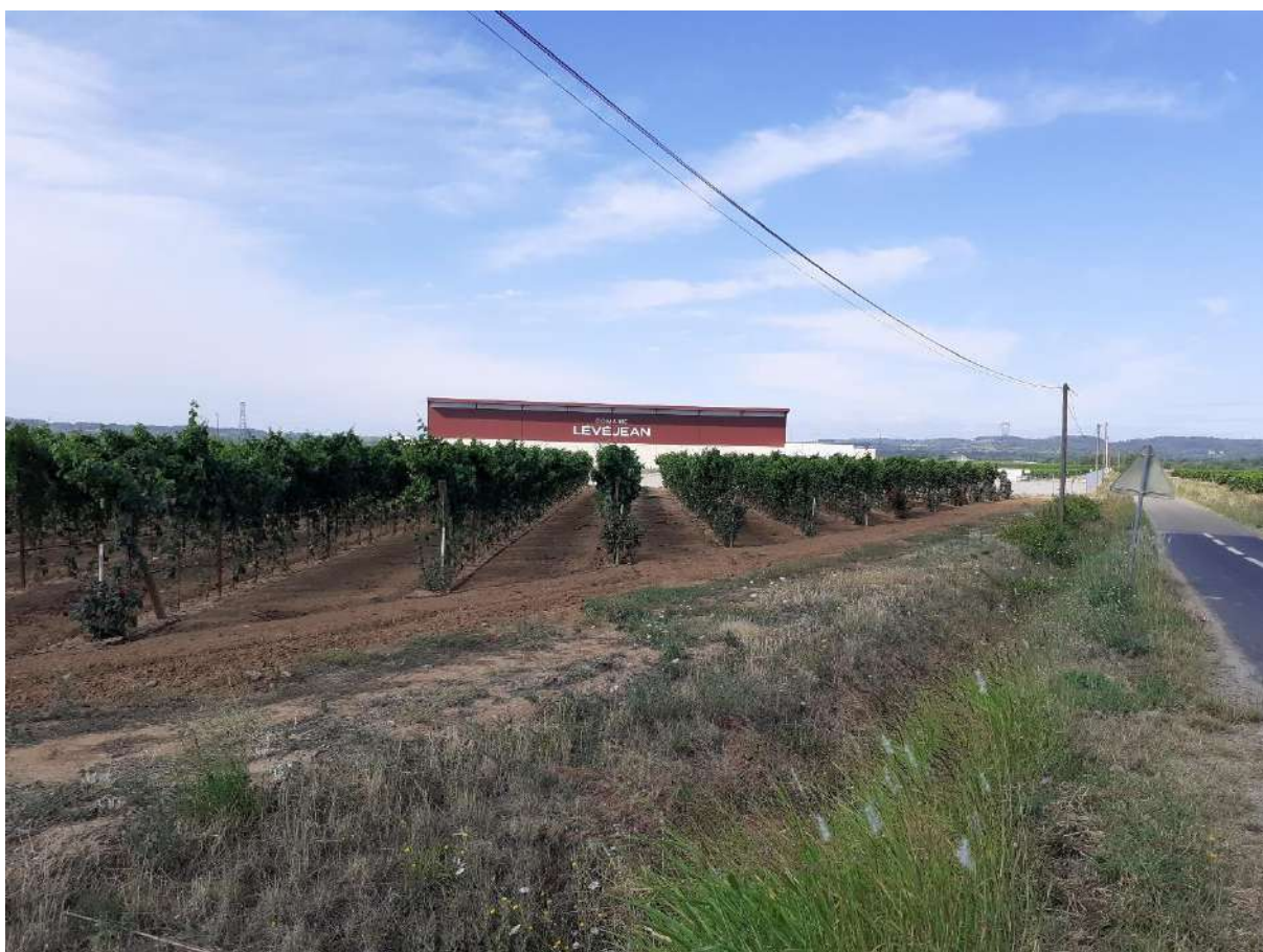
Figure 101. Cave particulière à l'écart du tissu bâti historique à Thézan-Lès-Béziers.
