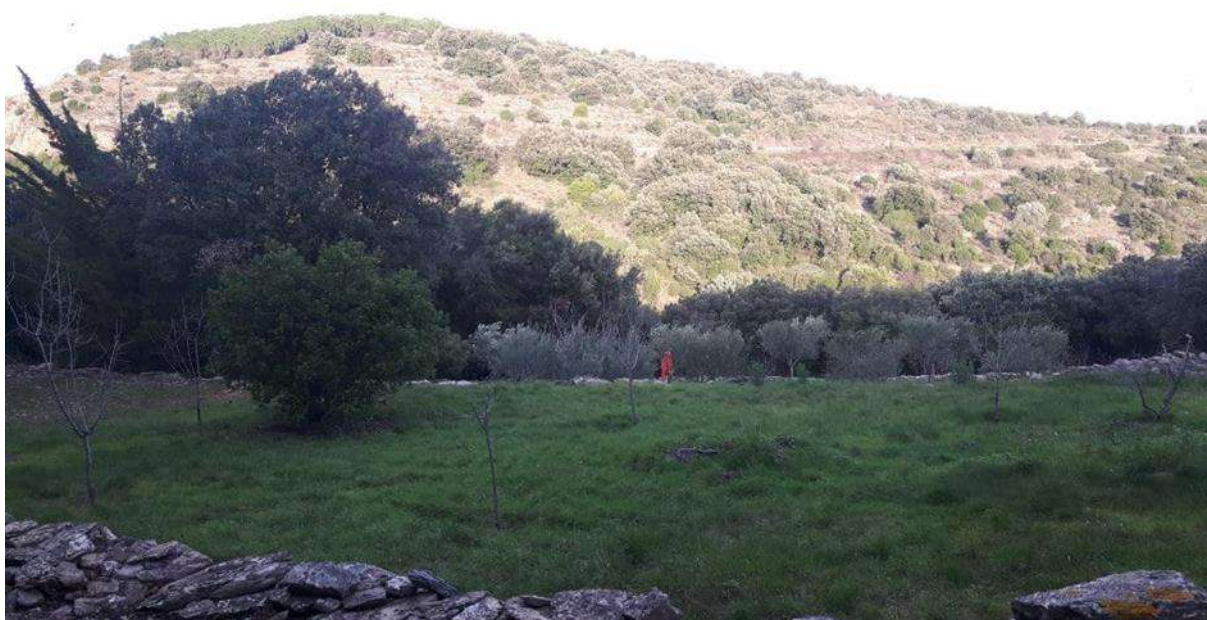
Figure 59. Terrasses soutenues par des murets maçonnés en pierre sèche à Faugères.
