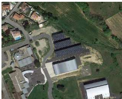
Figure 55. Vue aérienne de l'installation photovoltaïque à Murviel-Lès-Béziers
