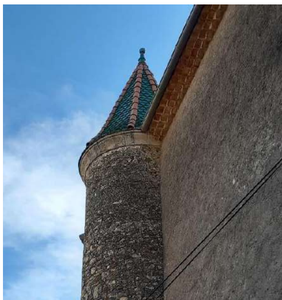
Toiture des tours du château de Laurens (actuelle Mairie)
