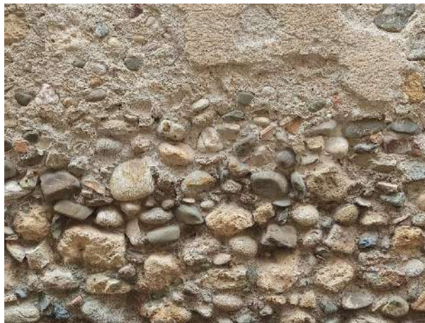
Exemple de façade en galets roulés à Thézan-lès-Béziers
