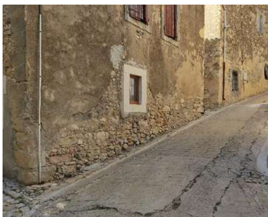
Exemple de façade enduite à Puissalicon
