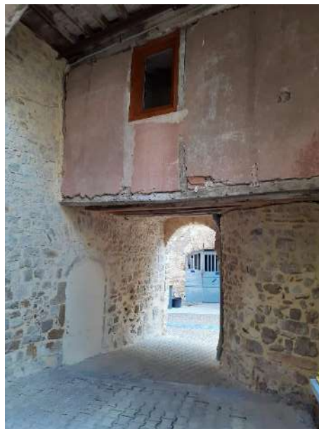
Architecture à pans de bois à Causses-et-Veyran
