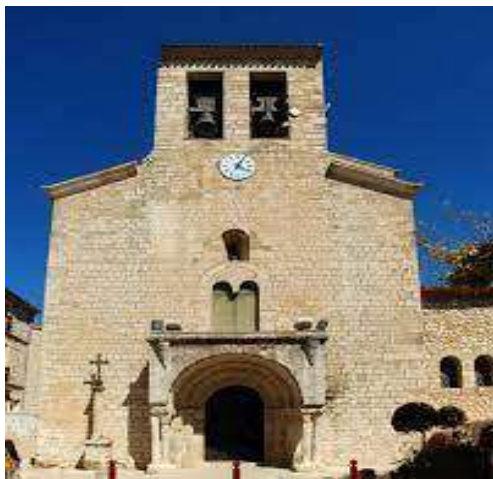
1- Eglise paroissiale de Saint-Laurent.
