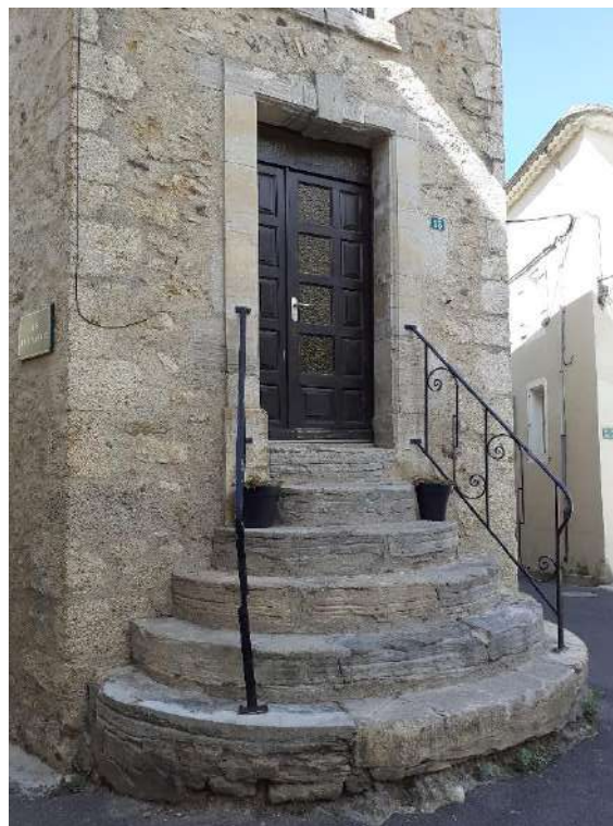
Exemple d'escalier extérieur à Autignac
