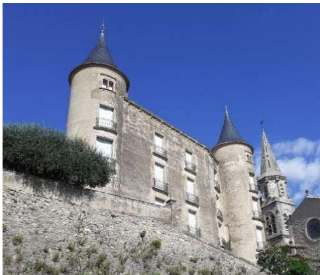
Toiture des tours du château de Pou
