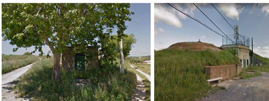
Figure 63. Réservoirs d'eau à Pouzolles et Roujan.
