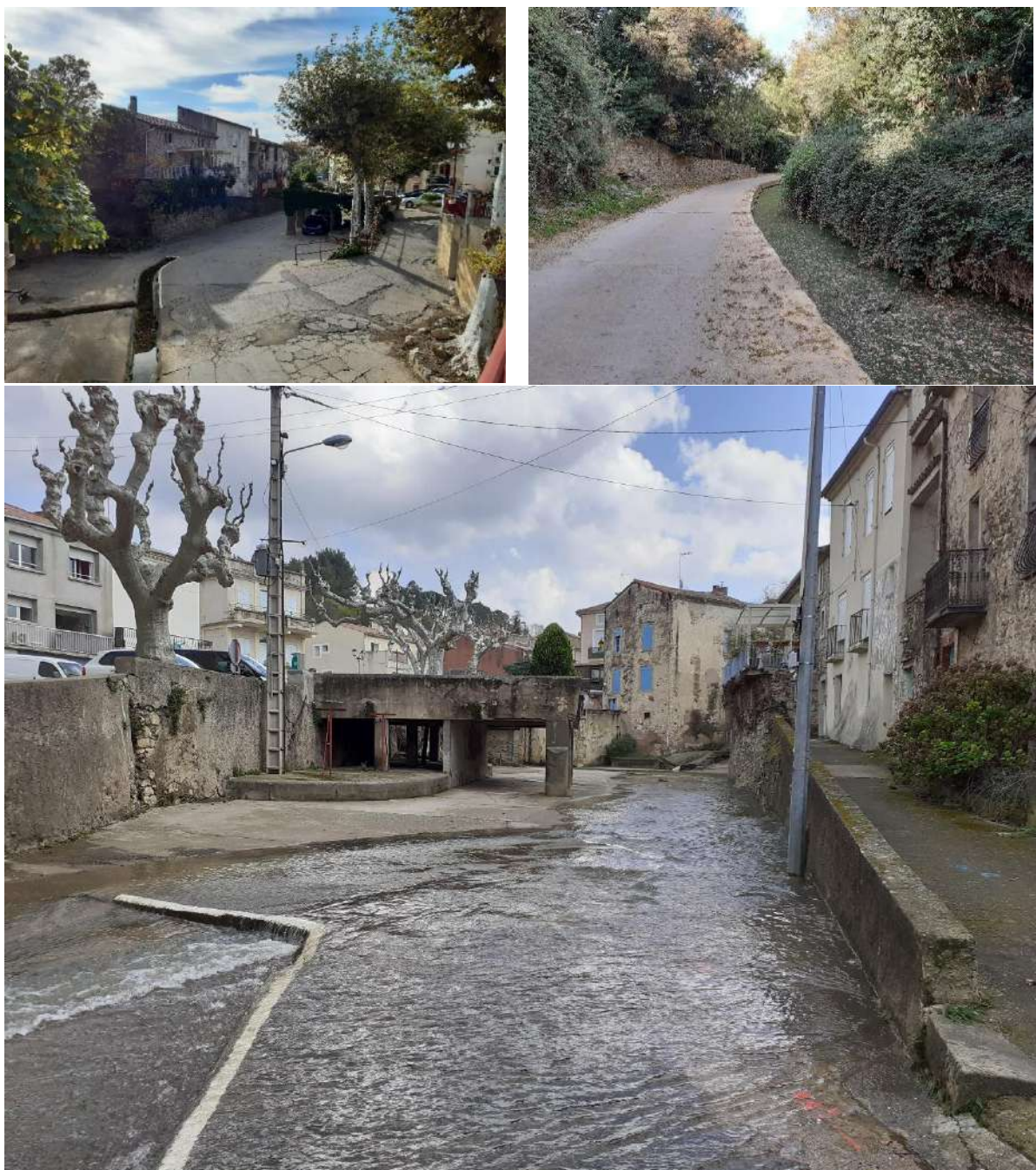
Figure 31. Problématique des recs et des ruisseaux circulant au cœur des venelles au sein de la commune de Laurens.
