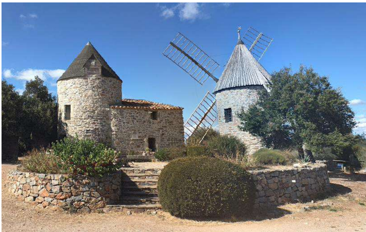
Figure 80. Moulins de Faugères.
