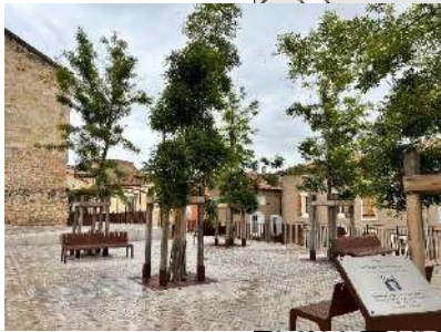
Aménagement de la place de la Tour
