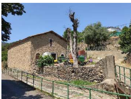
Grange agricole à l'intérieur du tissu bâti du village
