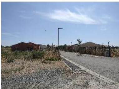
Développement pavillonnaire en cours
