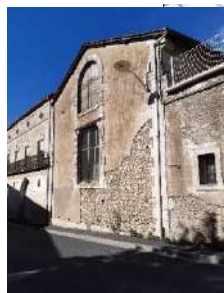
Remise et bâtiment d'activité vacants
