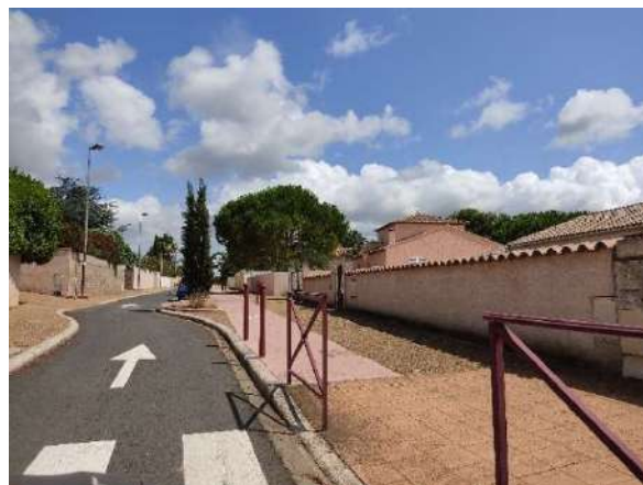
Exemple de voie partagée à Puimisson
