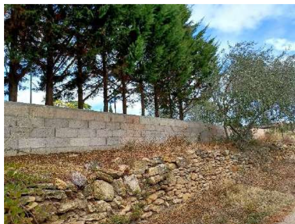
Muret en pierres sèches surmonté d'un mur en béton à Neffiès
