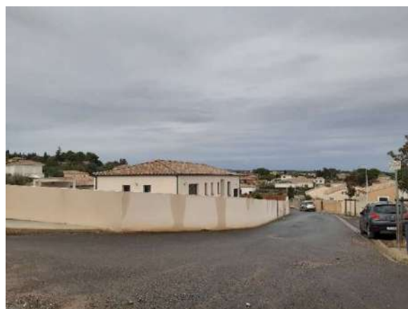
Voie de desserte d'un lotissement dépourvue d'arbres à Magalas
