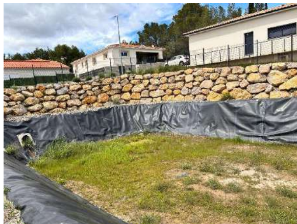
Exemple de bassin de rétention à Gabian
