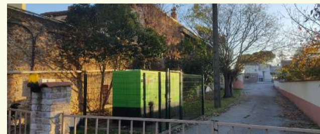
Photo n°3 : Voie d'accès au site
