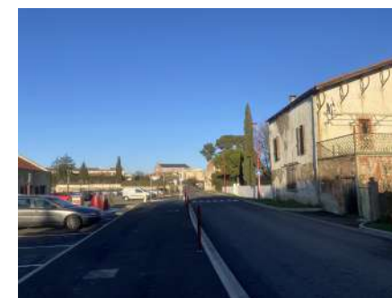
Photo n°4 : Rue Colombie, parking de l'école
