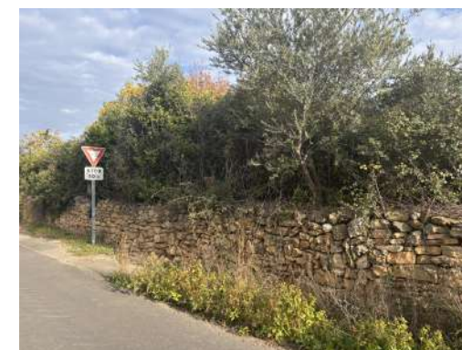
Photo n°2 : Muret de soutènement
