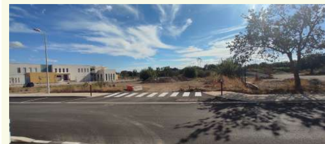
Photo n°2 : Entrée du site- La nouvelle école et son parking sont visibles
