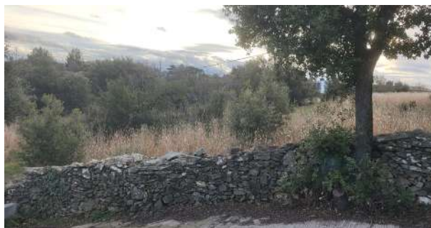
Photo n°4 : Muret en limite Est
