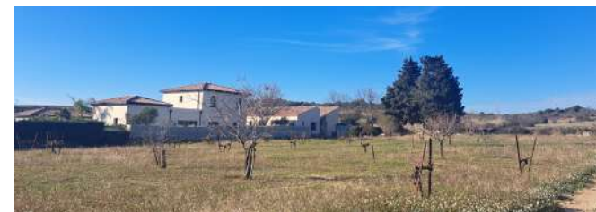
Photo n°1 : Vue générale et contexte bâti pavillonnaire en arrière-plan
