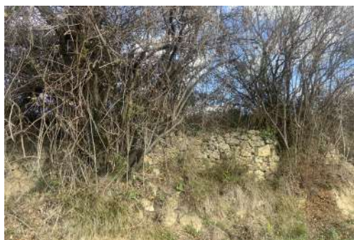
Photo n°4 : Muret de soutènement
