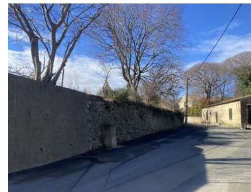
Photo n°1 : Mur donnant sur le Cami de Pézenas
