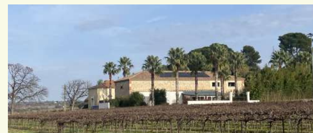
Photo n°2 : Vue des bâtis existants
