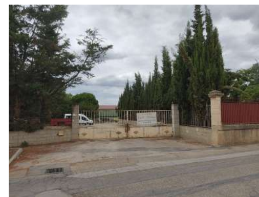
Photo n°3 : Accès au bâtiment d'activité présent à l'Ouest
