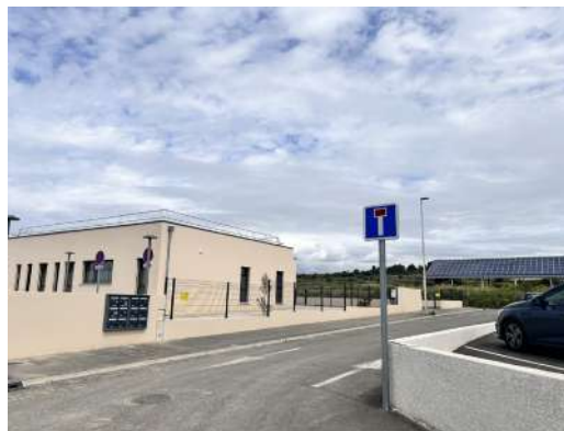
Photo n°4 : Impasse (rue de la Huppe) avec amorce de voie de desserte (site Nord)- Vue de la maison de santé
