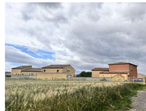
Photo n°2 : Vue côté Ouest boulevard des Condamines
