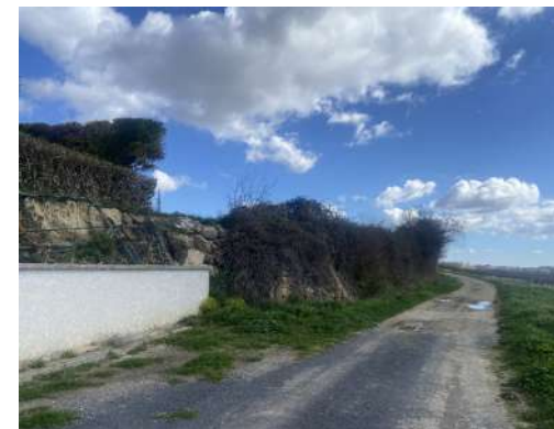
Photo n°1 : Vue vers l'Est depuis la rue de la Caunette
