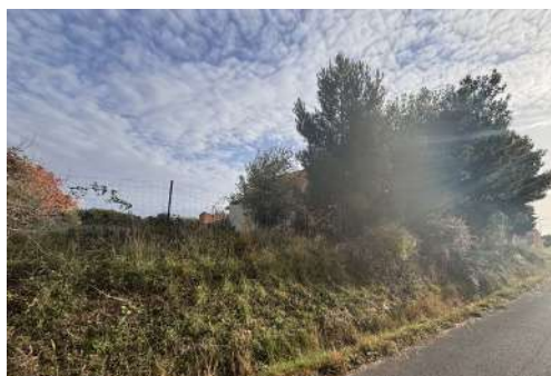
Photo n°4 : Muret de soutènement recouvert
