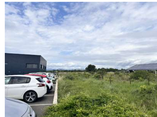
Photo n°5 : Extrémité de la seconde impasse donnant sur l'extension Nord
